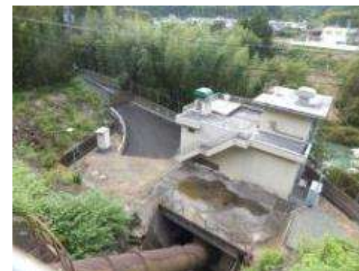
波多瀬発電所
