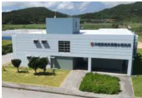
沖縄県海洋深層水研究所 ©2025 JMA Consultants Inc.
