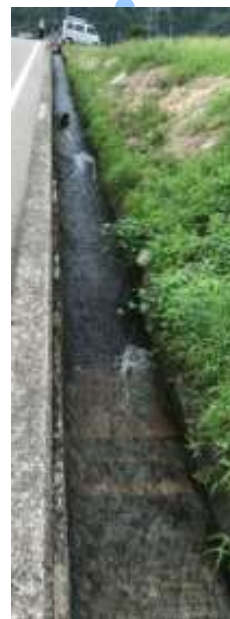
農業用水 排水路
