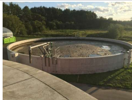
消化液貯留槽
