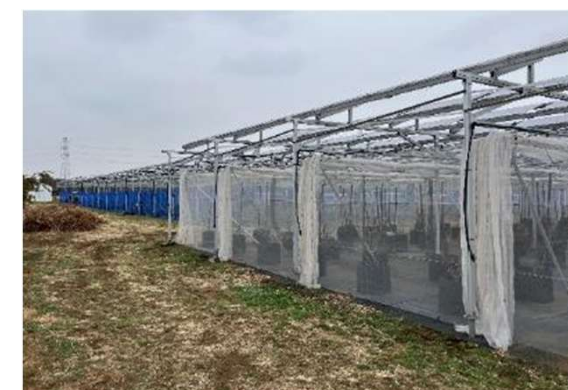
太陽光発電設備
