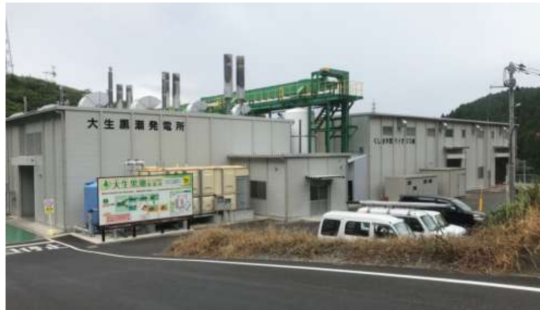
大生(おおばえ)黒潮発電所の外観
