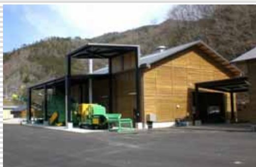
第三セクターにより運営される木質ペレット製造工場
