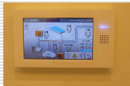
写真：とよたエコフルタウン内のスマートハウスに設置されたHEMSコントローラー
