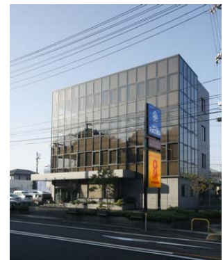
下関市綾羅木にある本社ビル
