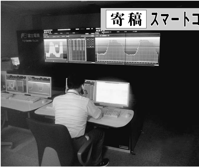
北九州の実証事業で設置された地域節電所。電力需給状況がタイムリーに管理されている
