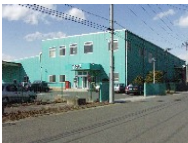
図 3-2 工場(西棟)概観
