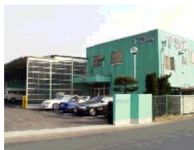
図 3-3 工場(東棟)概観
