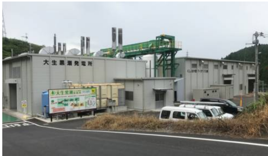
大生(おおばえ)黒潮発電所の外観
