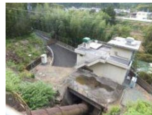
波多瀬発電所
