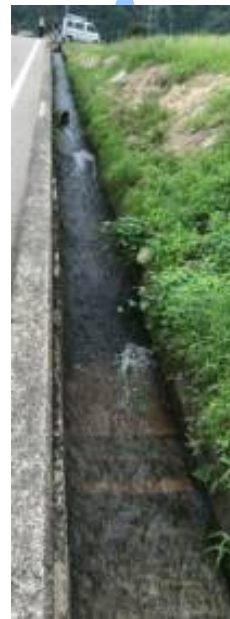
農業用水 排水路
