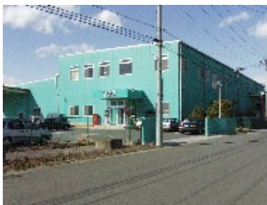
図 3-2 工場(西棟)概観
