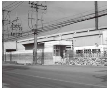
▲浸水した工業団地では、白塗りの壁を見れば、どこまで水が来たか一目瞭然である
