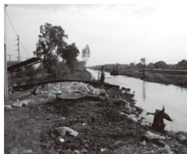
▲浸水した工業団地内の排水作業も進み、12月に入り、ようやく完全にドライな状況が回復された
